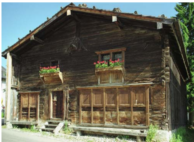
Geburtshaus von Ulrich Zwingli (1484 – 1531) in Wildhaus SG, Baujahr 1451. Es wird vermutet, dass das noch gut erhaltene Bauholz nach den geschilderten Traditionen gefällt wurde
